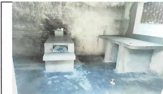
Foto 3: Se construyo nueva estufa de concreto y mesa de trabajo para sustituir las que estaban inservibles
