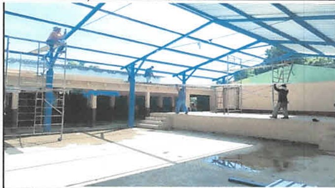
Foto 2: Se resano la estructura y se cambió la lámina galvanizada que ya había cumplido su vida útil.
