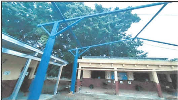
Foto 1: Se trabajó en el remozamiento de la estructura con el lijado y reparado de piezas en mal estado, además de subir a la altura de la estructura con columnas de metal sobre las de concreto.
