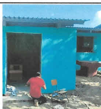
Foto 4: La puerta de la cocina está siendo sustituida por otra puerta fabricada de metal
